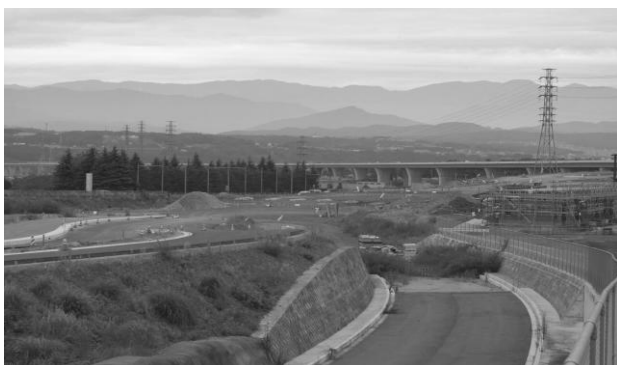
第二東名のインターチェンジ建設現場。ここで 「フリーター、家を買う。」のロケが行われて います。
