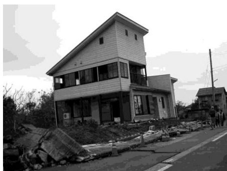
崖地、地滑りにより地盤ごと傾斜
