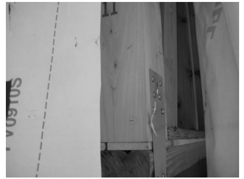
緊結しなければならぬ土台と柱の間に板が挟まれている
