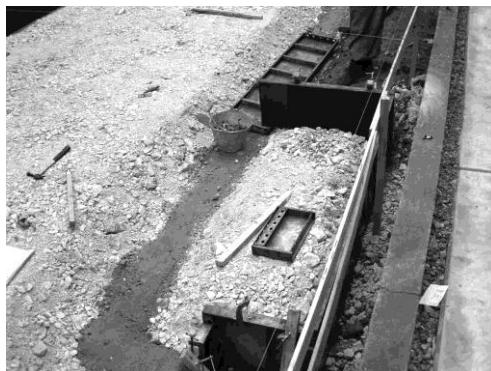
攪乱した地盤上に基礎工事
