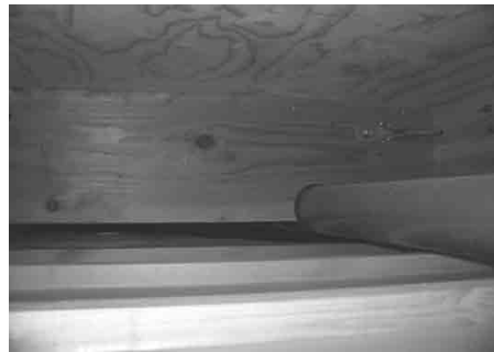
2F 梁下部分を欠き込んで配管を通して
