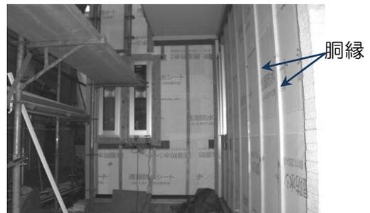
外壁通気構法の施工事例。
