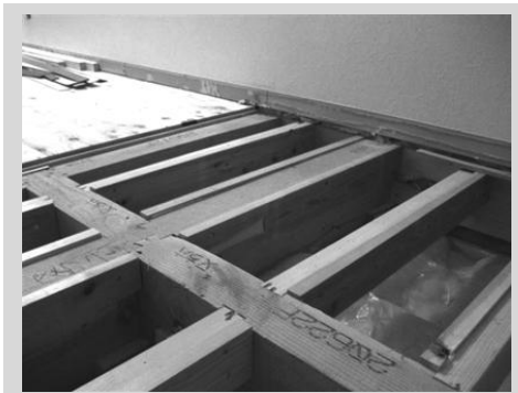
2階の床の根太：不陸修正のために入れた添え根太
