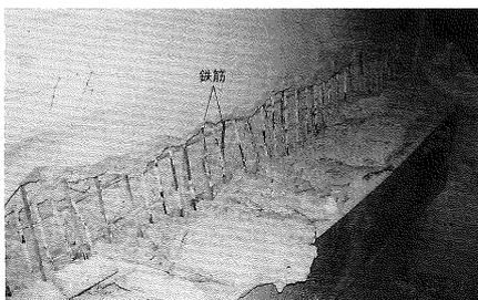
配筋検査で合格しているはずの鉄筋コンクリート作りの壁筋の台直し(鉄筋を急に曲げる)による鉄筋工事の欠陥(違法)が地震で露呈したケース
