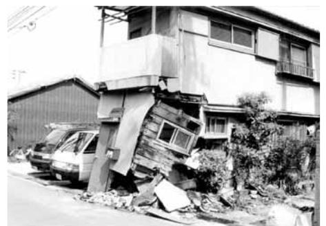
被害が目だった、壁のバランスを欠いた木造軸組工法の建物
