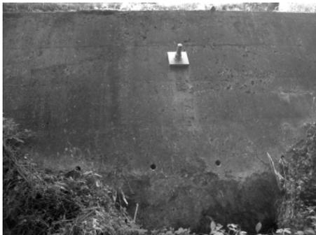
高町団地の擁壁。中央の突起はアースアンカー。下部の点は水抜き孔。
