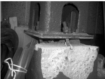
鉄骨造でのアンカーボルトの台直し不良という欠陥が被害を大きくしている。
