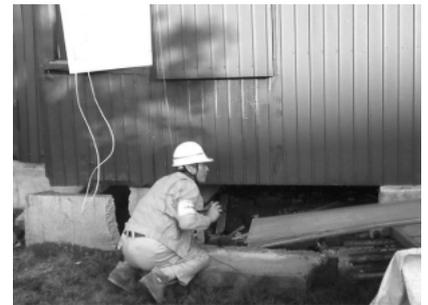
鉄筋もアンカーも無い基礎で基礎が折れて横に倒れた。
