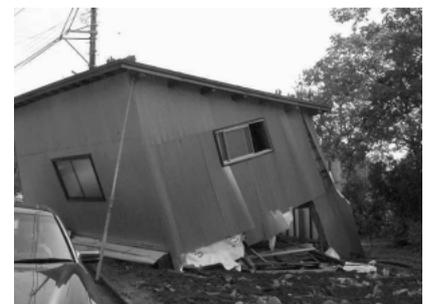
1階が柱のみで壁のない建築物は足払いを受けたような形で簡単に倒壊した。
