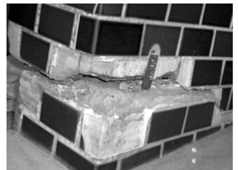
アンカーボルトのナットの締め忘れのため、壁が一旦浮き上がって、写真の位置に移動した。
