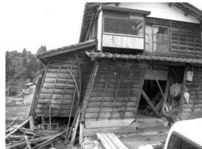
一階部分が破壊した木造家屋。正しく修復して、まだまだ住んでいただきたい。
