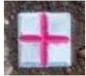
【十字のコンクリート杭】
