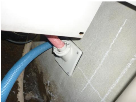
基礎貫通部漏水防止具付
