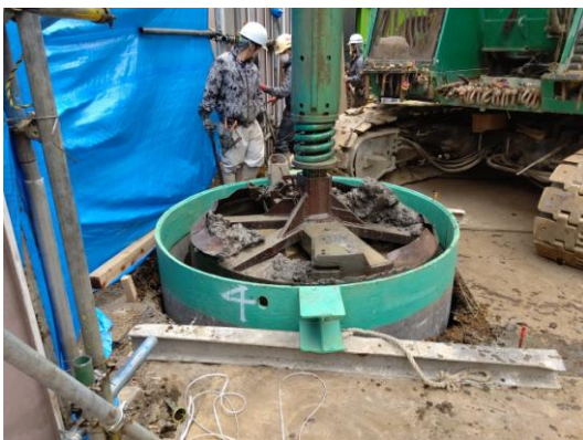
場所打ち杭工事
