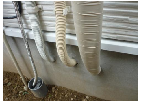
雨漏り要因基礎貫通配管
