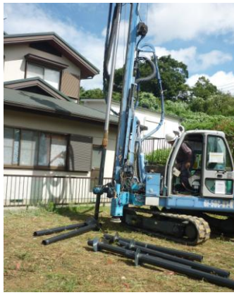
戸建て鋼管杭工事
