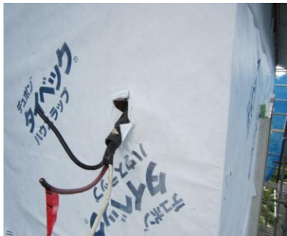
貫通部施工不良電気配管
