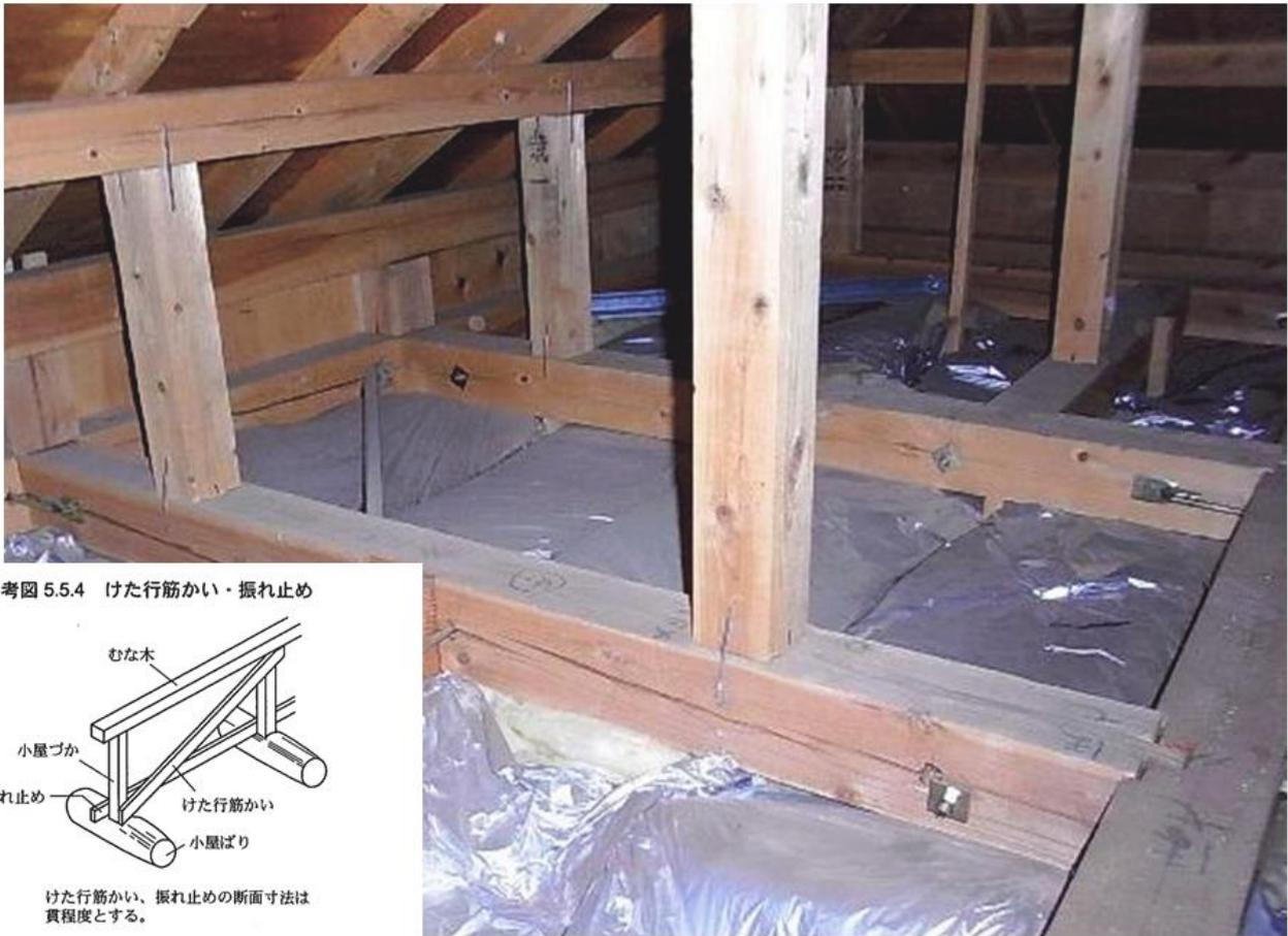
参考図 5.5.4 けた行筋かい・振れ止め
