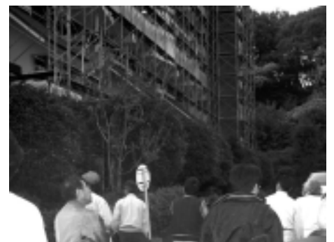
まだ足場のかかるマンションの修繕工事現場を、参加者の皆さんで見学
