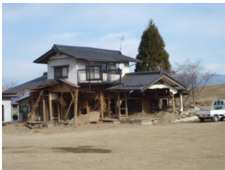
1階屋根から上だけ残る住宅
