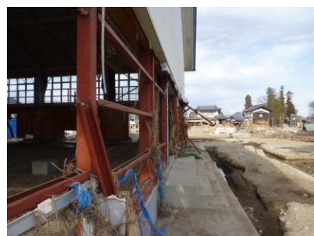
長沼体育館 外壁
