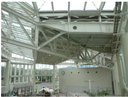
天井面にトラス梁を使った商業施設
