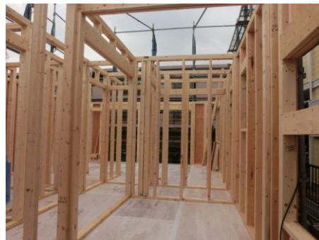
木造壁式構造 (枠組壁工法)
