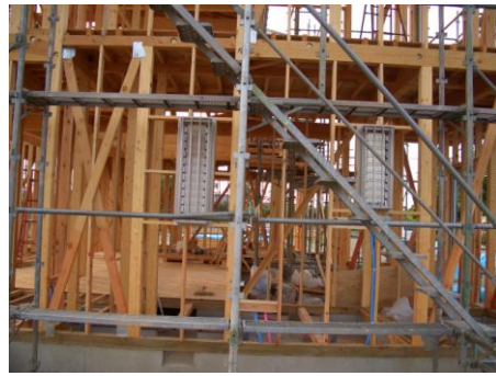
木造在来軸組工法
