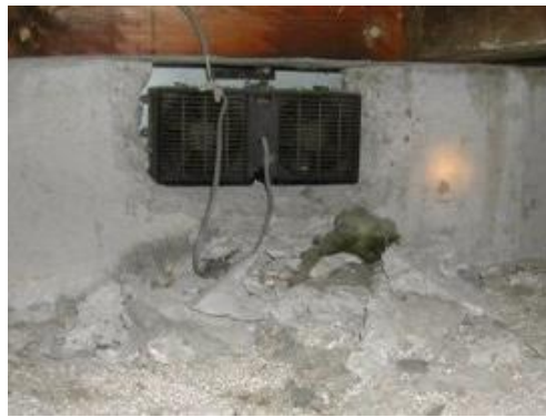
床下換気孔周囲のコンクリートを壊して換気扇を取り付けた事例
