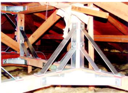
小屋裏の至る所に金物が取り付けられた事例
