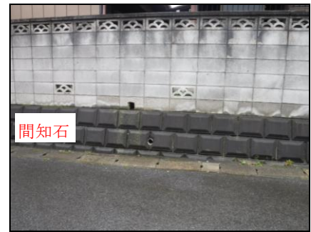
間知石の上にブロック塀 (ブロック塀の基礎は?)
