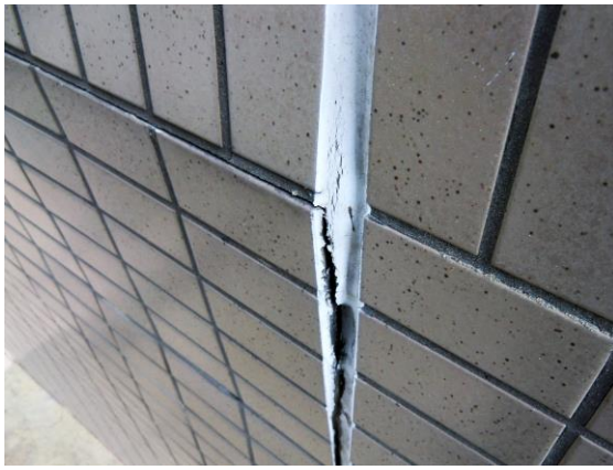
(写真-4)「直張り工法」
