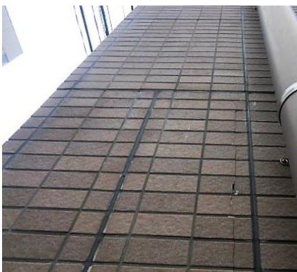
(写真-1) 「押出成形セメント板」下地
