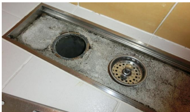
使われていた排水口と流し用排水金物
