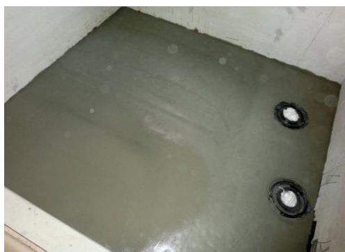
浴室基礎コンクリートと防水排水金物
