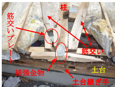
② 土台同士、柱、筋交いの接合部が集中
