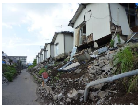
③ 盛り土地の擁壁崩壊に伴い基礎も崩落
