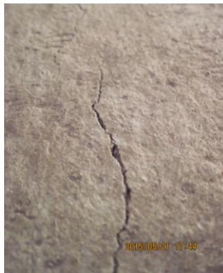
ベタ基礎の亀裂(参考)
