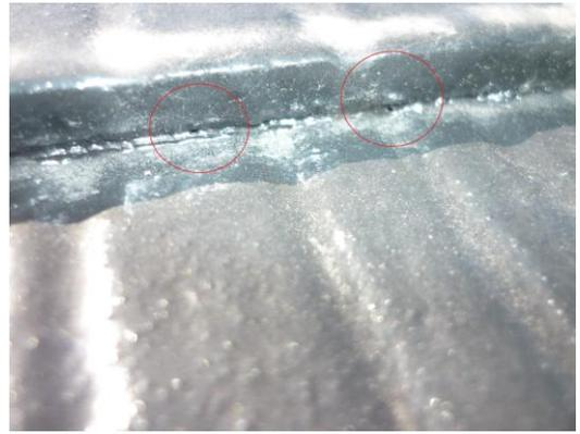
水は高いところから低いところへ流れるのは自然なことであるが、ピンホール等から毛細管現象による水の流れは屋根の勾配を逆に上ることがある。それにより雨漏れを発生させてしまうメカニズムとなります。
