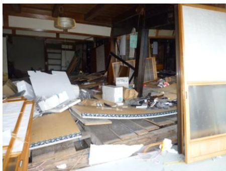
断層上の建物被害
