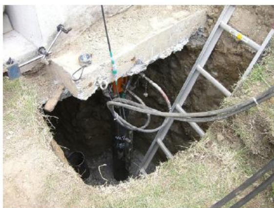
写真 1 鋼管圧入状況
