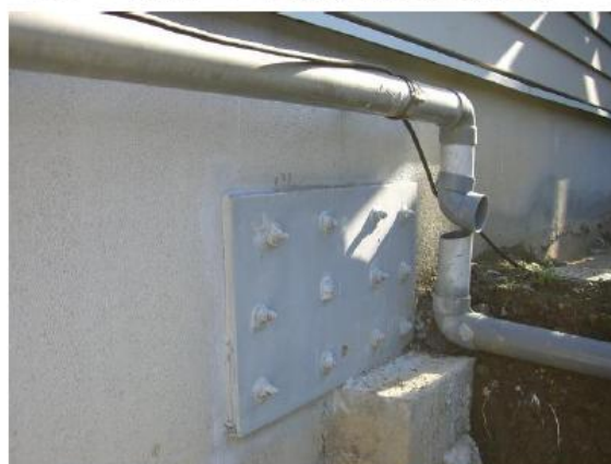
写真 4 基礎立上り側面の鉄板補強
