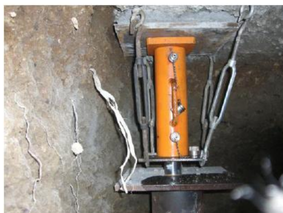
写真 2 鋼管圧入状況(鋼管杭頭部分)
