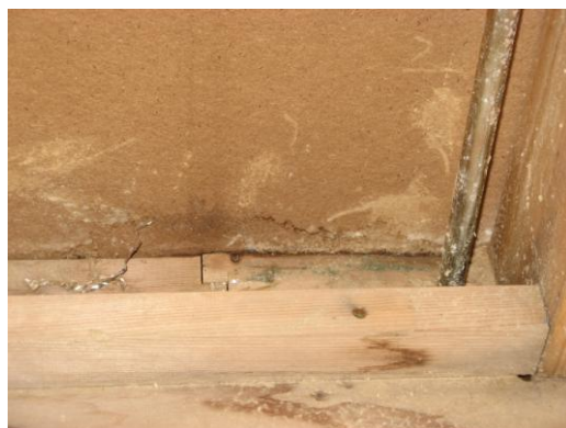
柱・胴差、構造用パネル、金物の状態
