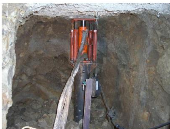
写真 3 鋼管圧入後の建物ジャッキアップ状況
