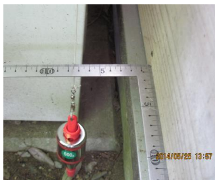
建物の傾斜測定
