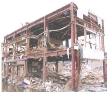
残存するS造建築物
