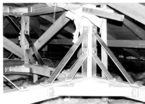
▲屋根裏の小屋束を取り囲むL字型の金物
