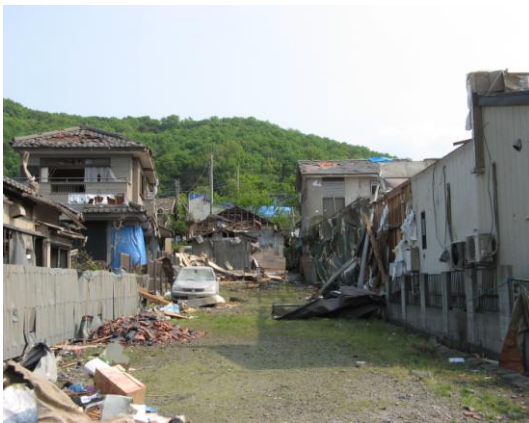
被害が著しい民家
