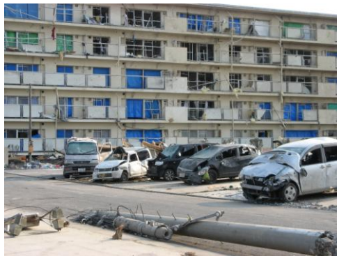
根元から折れた電柱
