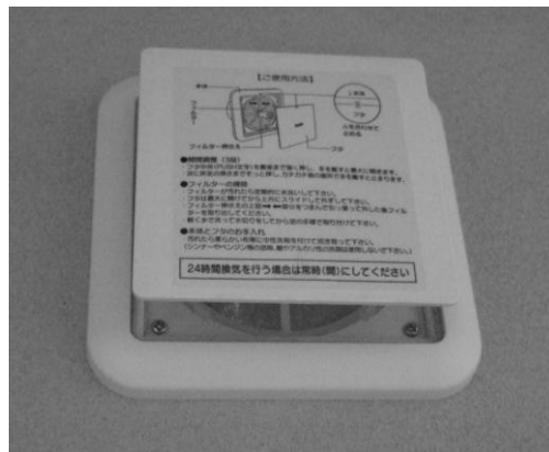
二十四時間換気の給気口を開けた状態
