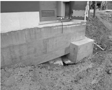
建物周囲の地盤が浸食され、基礎の底部まで露出している。
