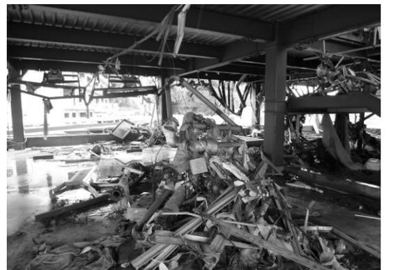
構造躯体のみが残存しており、柱等に大きな傾斜が生じている。
