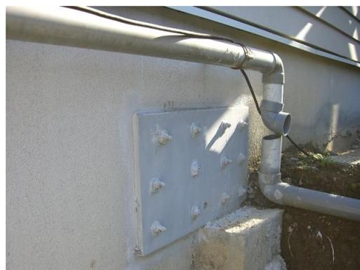
写真4 基礎立上り側面の鉄板補強
