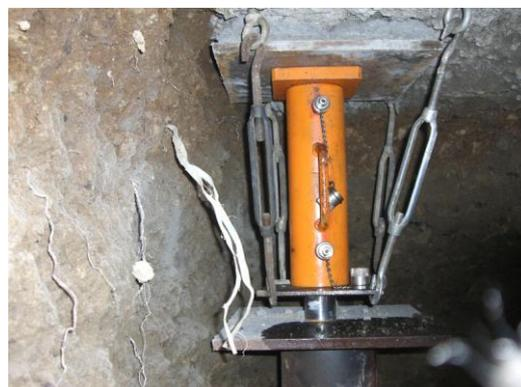
写真2 鋼管圧入状況(鋼管杭頭部分)
