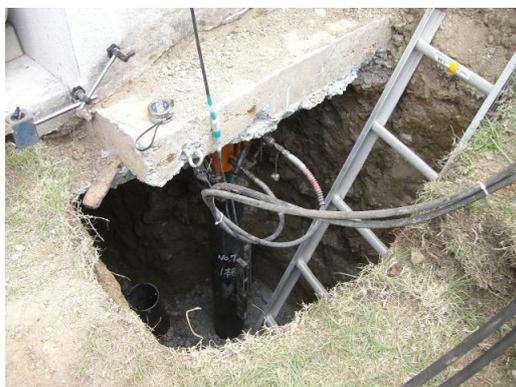
写真1 鋼管圧入状況
