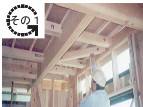
建物の調査・検査
