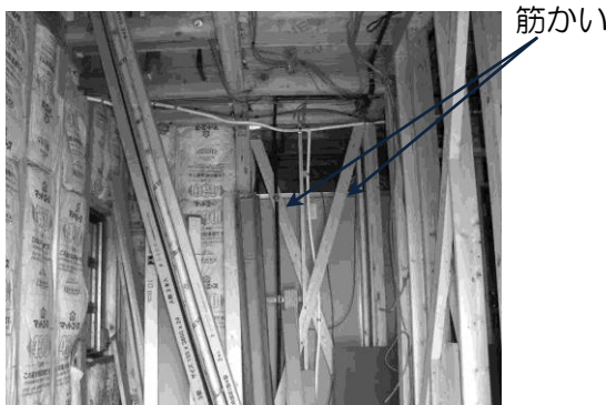
筋かいが、たすき掛けで施工されている状況
