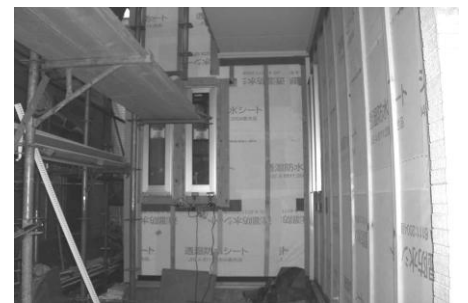
外壁の通気胴縁と通気層
