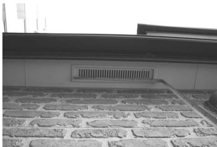
屋根軒天の小屋裏換気口
