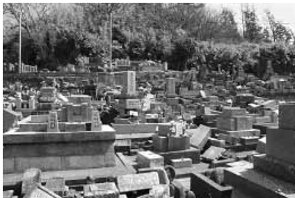
( 能登半島地震被災の様子-2 )
