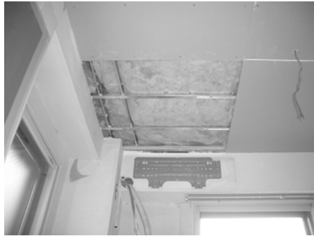
天井補修工事中
