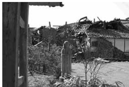
(能登半島地震被災の様子-1)
