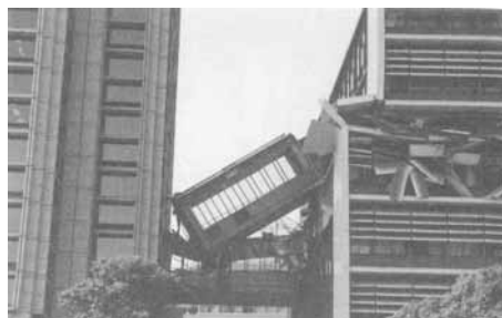
( 阪神淡路大震災の被災の様子 )
