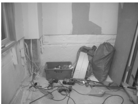
補修工事中。室内に粉塵が舞っている
