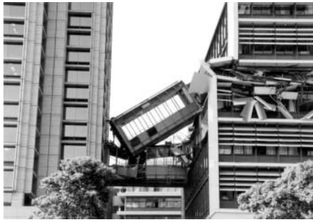
(イメージ写真) 阪神大震災により落下した、神戸市役所空中廊下。
