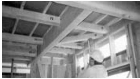
建築Gメンによる工事の第三者検査。欠陥住宅を防ぐ手立ては、信頼できる第三者の専門家に現場をチェックしてもらうこと。
