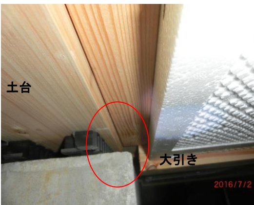
(写真-1)「土台」と「大引き」の仕口部分
