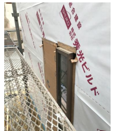
(写真-7) 外部建具廻りの防水工事
