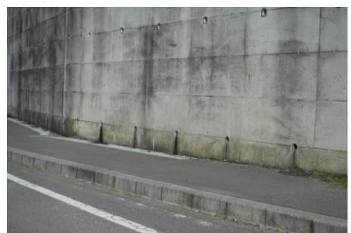
鉄筋コンクリート造の擁壁。一番最下段の水抜き穴から水が流れた跡がわかります。
