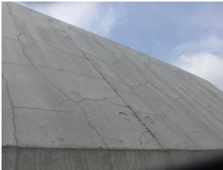
写真3: 打放し仕上げ(モルタル系)斜壁の著しいクラック現象
