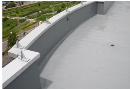
パラペットに鳩除けワイヤー設置
