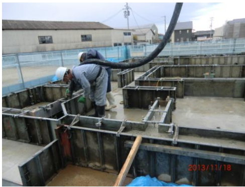
「基礎立ち上り」のコンクリート打設
