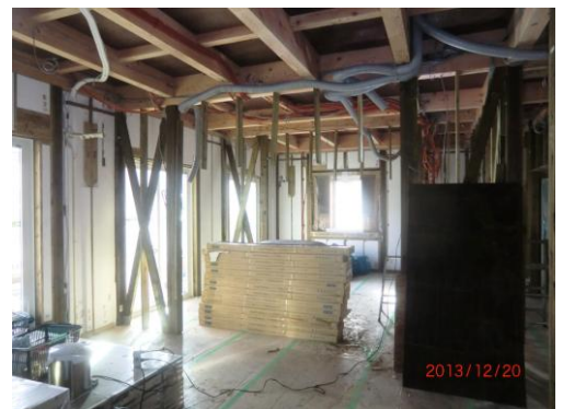
「軸組み」工事完了
