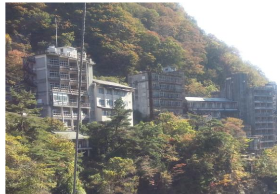
(写真は鬼怒川右岸の廃屋の群れ)
